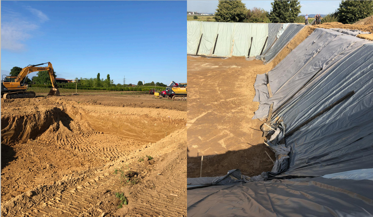
Bau eines dritten Wasserspeicherbeckens für die erweiterten Stellflächen
